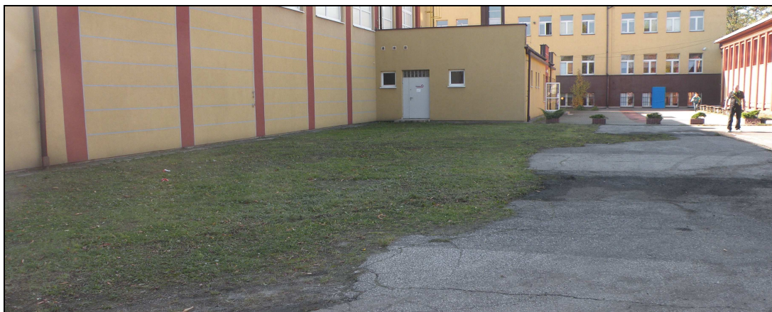
FOT 1. Widok boiska z nawierzchnią asfaltową oraz placu z kostki betonowej przed szkołą
