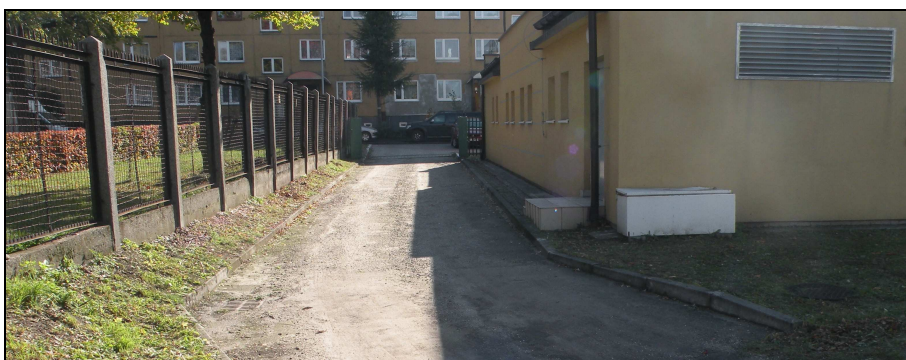
FOT 4. Widok istniejącego zjazdu oraz ogrodzenia przewidzianego do demontażu
